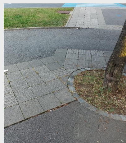
Slika 70: 1.(ustrezno) Primer ureditve v višji stopnji dostopnosti, kjer izvedba vodilnih linij na pločniku ni smiselna. Ker je prostora na pločniku premalo, je ustrezne vodilne linije nemogoče izvesti, saj bi bile prekratke. Preveč oznak na majhnem prostoru lahko bolj zmede uporabnika, kot bi mu koristilo. Ker gre za semaforizirano križišče, v tem primeru orientacijsko funkcijo prevzame zvočni semafor. Pešec, ki hodi ob robu, po zvoku najde semafor. Zelo pomembno je, da so vodilne linije, ki vodijo čez zebro, postavljene tako, da povezujejo oba semaforja. 2. (neustrezno) Primer oznak, kjer je na majhnem mestu veliko tipnih tekstur, ki jih je s palico nemogoče prepoznati.
