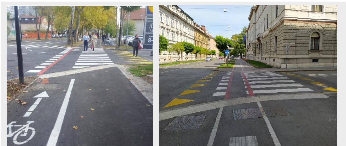
Sliki 53 (ustrezno): Oznaki roba peščeve površine na prehodu za pešce. 1. Oznaka sega od roba ene do roba druge zelenice in tako ščiti ljudi z okvarami vida pred tem, da bi zašli na vozišče. 2. Oznaka na dvignjeni trapezni ploščadi mora segati tudi izven zebre, vse do mesta, kjer je višinska razlika med voziščem in površino za pešce že dovolj visoka, da jo lahko zaznamo s tipom (3 cm).
