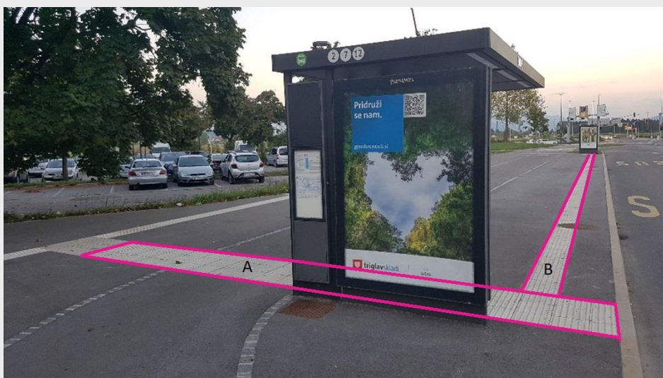
Slika 59 (ustrezno): Primer postajališča, označenega s kompleksnim taktilnim vodenjem – del ob vstopnem mestu. Oznaka vstopnega mesta (A) je postavljena tako, da poteka neposredno ob informacijskem stebru. Taktilna vodilna linija (B) poteka vzdolž celega perona 60 cm od robnika ob cesti in se (brez čepaste oznake!) pripenja na oznako vstopnega mesta. Ta linija je pomembna zato, da pri izstopu iz avtobusa uporabnik bele palice lahko najde pot do roba pločnika.
