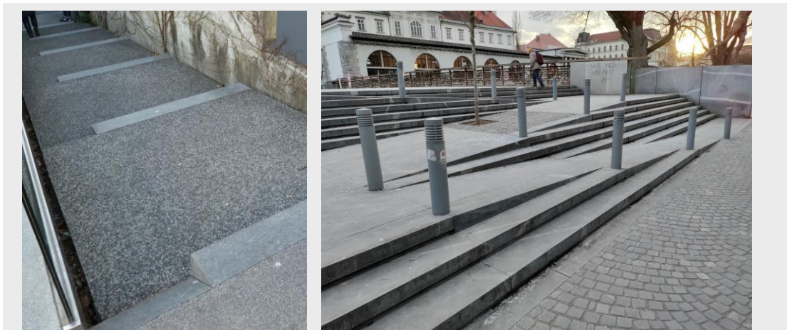
Sliki 37 (neustrezno): 1. Nestandardno stopnišče z dolgimi nastopnimi ploskvami, ki otežuje hojo. V tem primeru uporabo še dodatno otežuje dejstvo, da je del stopnice poševen. Sredi stopnice je rob, ki je zelo nevaren za padec, še toliko bolj zato, ker robovi niso kontrastni in jih je zelo težko zaznati. 2. Stopnišče z integrirano klančino je vključujoče le na prvi pogled, sicer pa je za večino uporabnikov s funkcionalnimi oviranostmi neuporabno.
