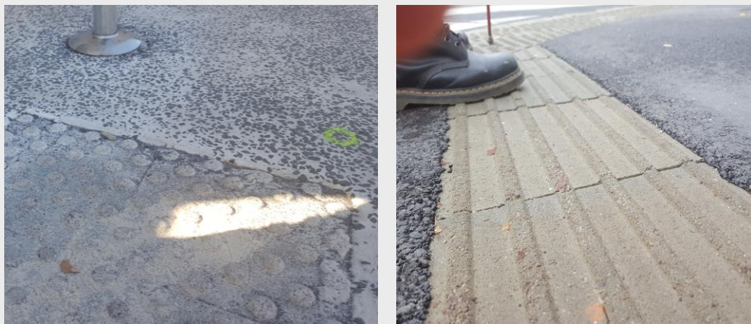
Sliki 50 (neustrezno): Primera slabe izvedbe oznak, ki so ugreznjene glede na okoliški tlak in zato s palico in podplati zelo težko zaznavne.
