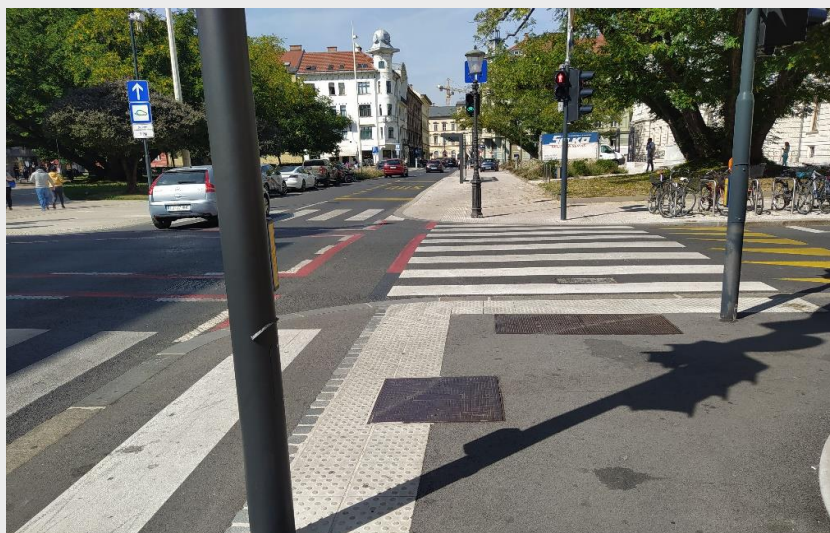
Slika 54 (ustrezno): Označitev roba varne površine s čepastimi oznakami v nivojskem križišču v primeru, ko teče kolesarski pas ob cesti. Zvočni semafor je postavljen neposredno ob čepasti oznaki.
