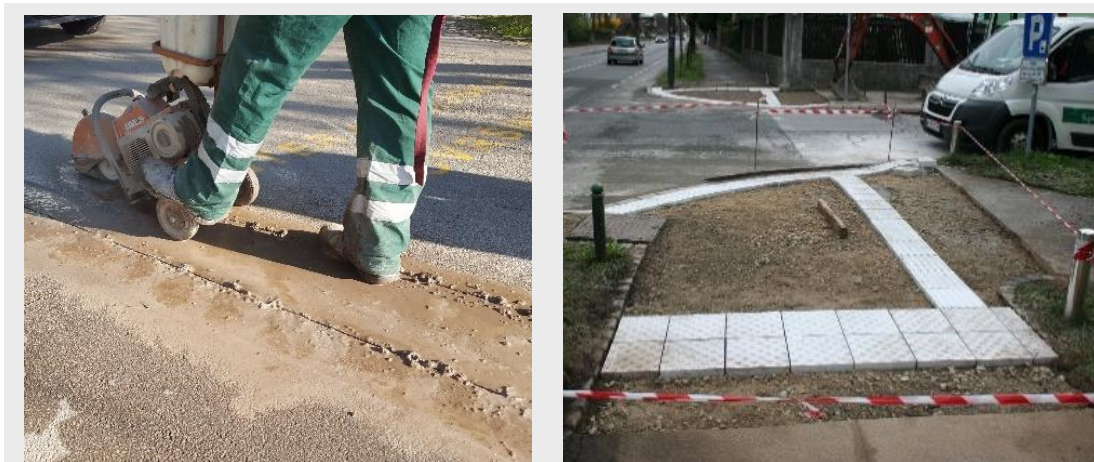
Sliki 47: Načina vgradnje taktilnih oznak v asfaltno površino. 1. Način naknadne vgradnje betonskih oznak - rezanje asfalta. 2. Način predhodne vgradnje.
