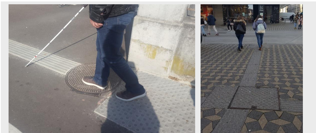
Slika 73: Taktilne oznake na jaških. 1. (neustrezno) Ko pešec z belo palico pride do čepaste oznake, mora najti oznako, ki vodi naprej. Ker je tik ob čepasti oznaki jašek, se vodilna oznaka ne dotika čepaste. Tako jo lahko otipa šele, ko stopi korak izven čepaste oznake, kar zelo oteži orientacijo. 2. (ustrezno) Uporabljeni so jaški za naknadno vgradnjo tlakov, pri katerih so taktilne oznake vgrajene v pokrov jaška.
