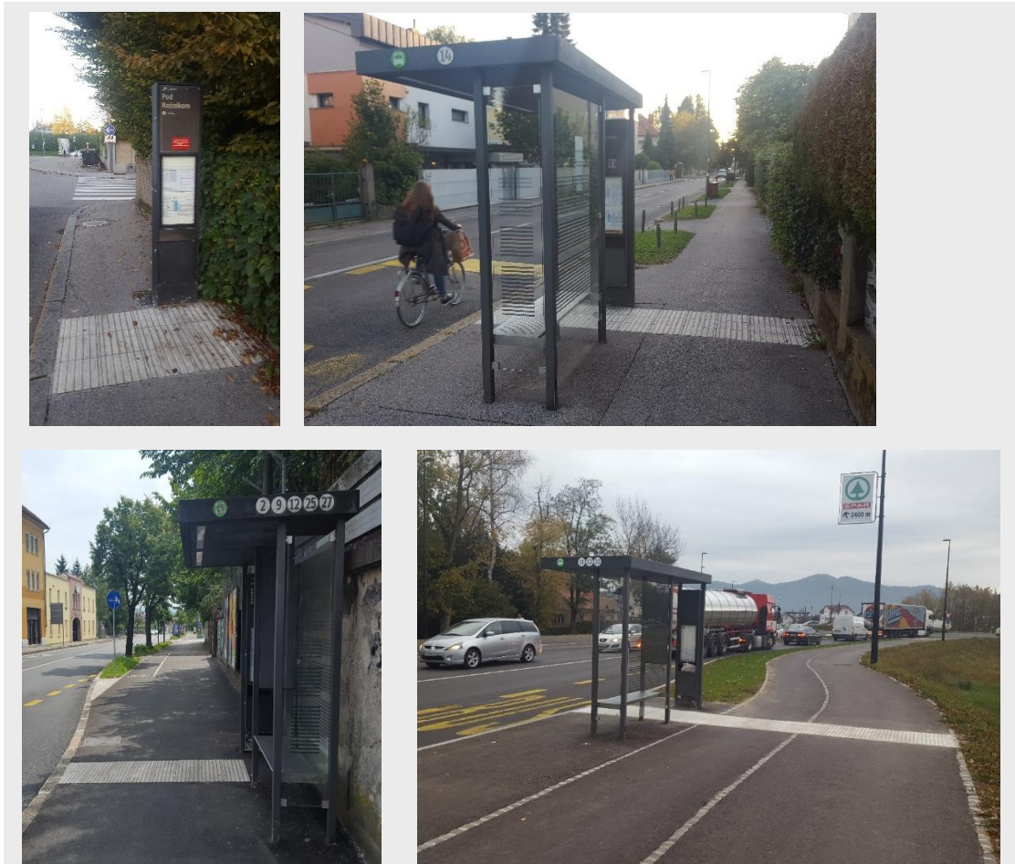
Slika 58 (ustrezno): Primeri oznak vstopnega mesta na preprostih postajališčih. 1. Primer označitve postajališča v primeru, ko ni prostora za postavitev nadstrešnice. Postajališče je označeno samo s taktilno oznako vstopnega mesta in info stebrom, ki stoji neposredno ob njej. 2. Primer postajališča z nadstrešnico, ki je ustrezno umaknjena s peščeve površine. Taktilna oznaka označuje neposreden dostop do info stebra in vstopnega mesta. 3. Primer z nadstrešnico ob robu pločnika. Taktilna oznaka je umeščena ob info stebri. 4. Primer, ko za čakališčem poteka kolesarski pas, taktilne oznake pa neprekinjeno vodijo tudi čez kolesarski pas.
