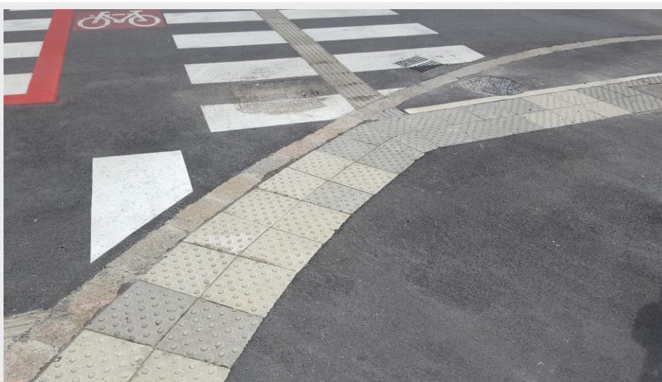
Slika 52 (neustrezno): Ob dopolnjevanju ureditve so bile uporabljene taktilne plošče različnih barv.
