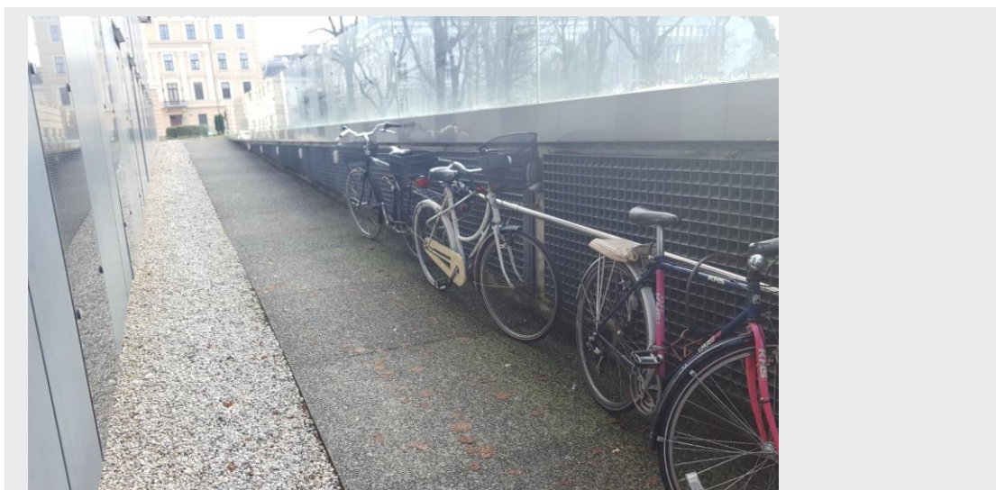
Slika 38 (neustrezno): Klančina, ki omogoča dostop z vozičkom do vhoda v objekt, ima oprijemalo načrtovano samo ob spodnjem delu na eni strani. Ker ob objektu ni načrtovanih parkirišč za kolesa, kolesarji uporabljajo oprijemalo za parkiranje koles.
