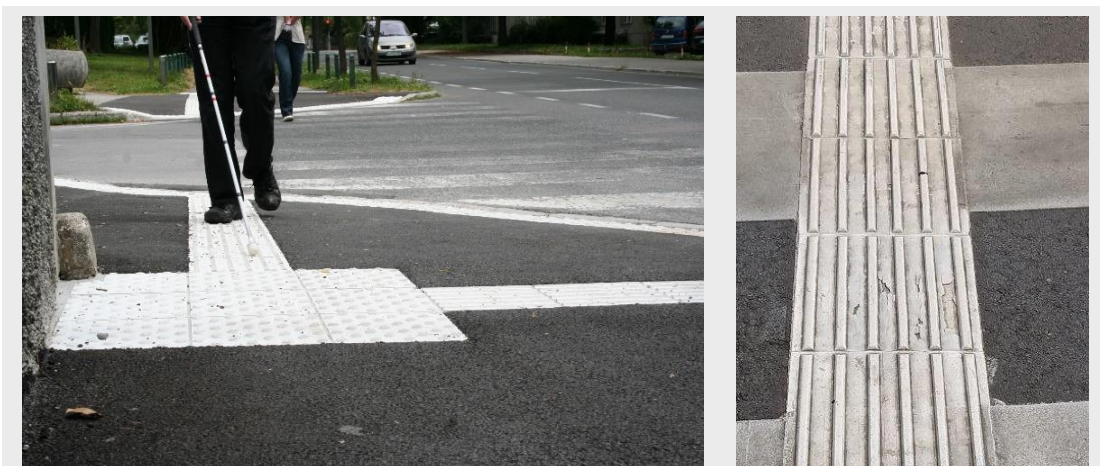
Sliki 45: Taktilne oznake iz različnih materialov 1. Betonske bele oznake na asfaltu. 2. Manj obstojne oznake iz umetnih mas, ki so lepljene na asfalt.
