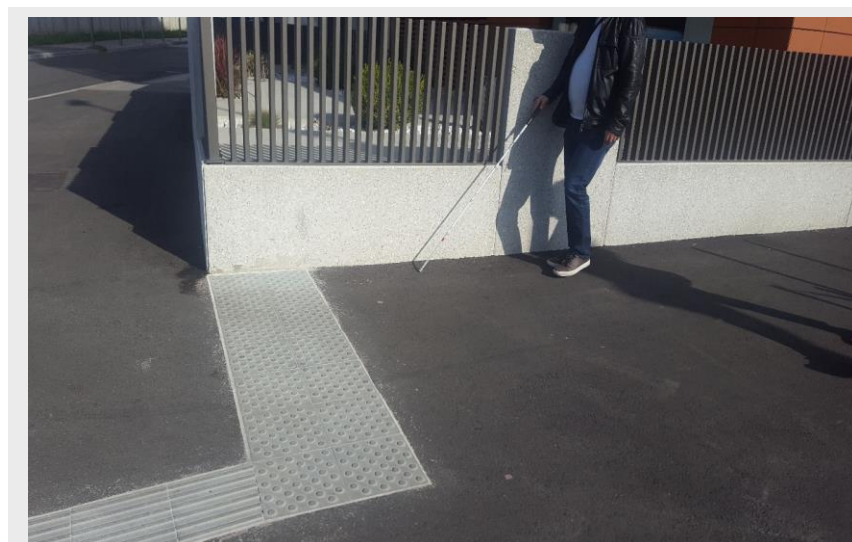
Slika 67 (ustrezno): Primer vodilne linije, ki je ustrezno navezana na rob s podolgovatim obvestilnim poljem.
