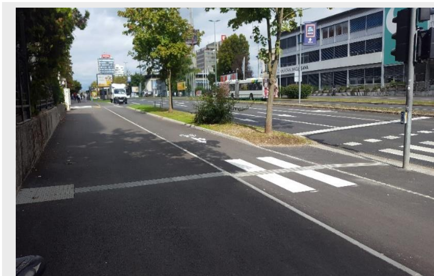
Slika 1 (ustrezno): Najbolj sprejemljiv primer ureditve z vidika oseb s funkcionalnimi oviranostmi in varnosti pešcev ter tudi pretočnosti kolesarskih stez je višinsko ločena kolesarska steza, ki pa je lahko uresničljiv le tam, kjer je prostora dovolj za ustrezno višinsko ločitev pasov in so oblikovani tudi dovolj veliki prostori za čakanje.
