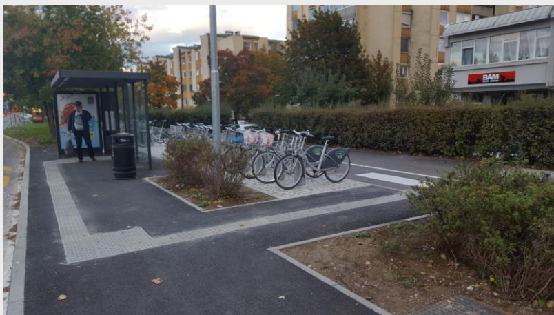
Slika 60 (ustrezno): Primer postajališča, kjer zaradi parkirišča za kolesa oznaka vstopnega mesta ne more biti neposredno vezana na rob, ampak jo je treba povezati s kompleksnim taktilnim vodenjem (čepastimi polji in vodilnimi linijami).
