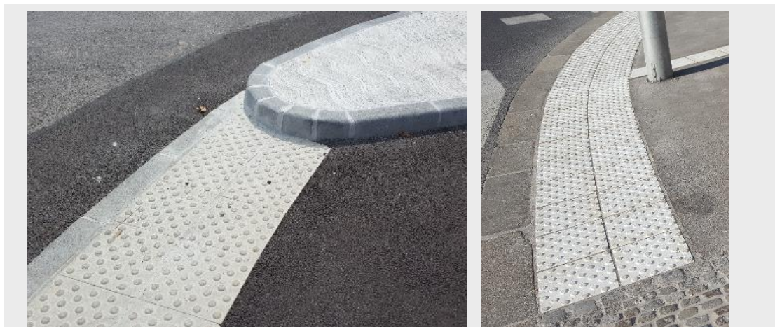
Sliki 49 (ustrezno): Primera natančne vgradnje betonskih oznak z različnima načinoma izvedbe. 1. Izvedba s predhodno vgradnjo. Taktilne oznake segajo do roba in so natančno zaključene. Struktura je nepoškodovana. 2. Izvedba z rezanjem asfalta.
