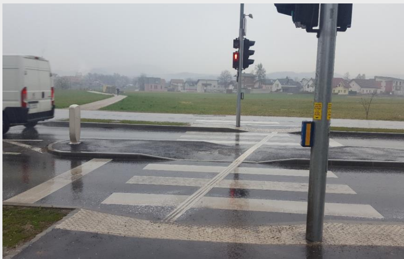
Slika 71: (neustrezno) Primer taktilne reliefne črte čez zebro, ki ni usklajena z lokacijami semaforjev. Taktalne vodilne linije morajo povezovati zvočne semaforje in so lahko največ 60 cm oddaljene od teh, da so uporabne.
