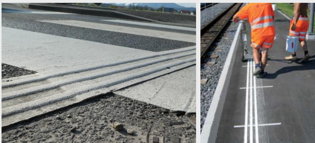
Sliki 51: Vodilne reliefne črte iz hladne strukturne plastike. 1.(neustrezno) Izvedba, ki je glede na standard previsoka in zato povzroča hrup. 2. (ustrezno) Označitev s posameznimi črtami, nanešenimi neposredno na asfalt.
