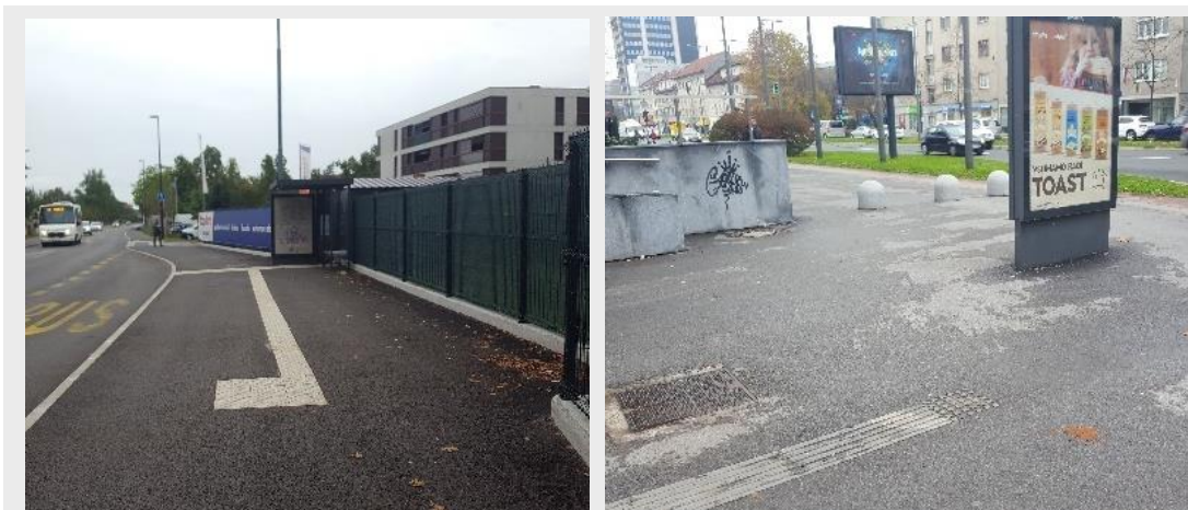
Slika 68 (neustrezno): 1. Taktilne oznake, ki niso povezane z robom in jih zato uporabnik bele palice ne more najti. 2. Poleg tega, da niso povezane z robom, taktilne oznake na sliki tudi niso izdelane v skladu s standardom. Polje, ki označuje začetek, je premajhno, oznake imajo taktilno nezaznavno strukturo in ker so tudi vizualno nekontrastne ne koristijo niti slabovidnim uporabnikom.
