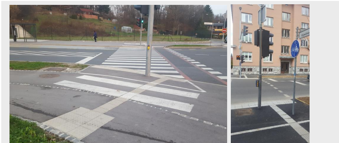
Slika 72: 1. (neustrezno) Primer oznake, ki usmerja pešca v napačno smer- v sredino križišča. 2.(ustrezno) Primer oznak, ki so usklajene na obeh straneh ceste.
