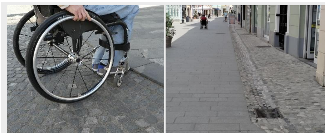
Sliki 27 (neustrezno): Ovire za uporabnike invalidskih vozičkov. Pri načrtovanju je treba določiti glavne smeri gibanja pešcev. 1. Če je predvideno, da se pešci gibljejo vzdolž robnika (npr. v območjih za pešce), je lahko takšen robnik ustrezen ukrep za olajšanje orientacije slepih in slabovidnih. 2. Tam, kjer je predvideno prečno gibanje pešcev čez muldo, pa takšna postavitev predstavlja oviro za prehod uporabnikov invalidskih vozičkov in je neustrezna.
