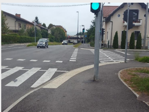
Slika 70: 1.(ustrezno) Primer ureditve v višji stopnji dostopnosti, kjer izvedba vodilnih linij na pločniku ni smiselna. Ker je prostora na pločniku premalo, je ustrezne vodilne linije nemogoče izvesti, saj bi bile prekratke. Preveč oznak na majhnem prostoru lahko bolj zmede uporabnika, kot bi mu koristilo. Ker gre za semaforizirano križišče, v tem primeru orientacijsko funkcijo prevzame zvočni semafor. Pešec, ki hodi ob robu, po zvoku najde semafor. Zelo pomembno je, da so vodilne linije, ki vodijo čez zebro, postavljene tako, da povezujejo oba semaforja. 2. (neustrezno) Primer oznak, kjer je na majhnem mestu veliko tipnih tekstur, ki jih je s palico nemogoče prepoznati.
