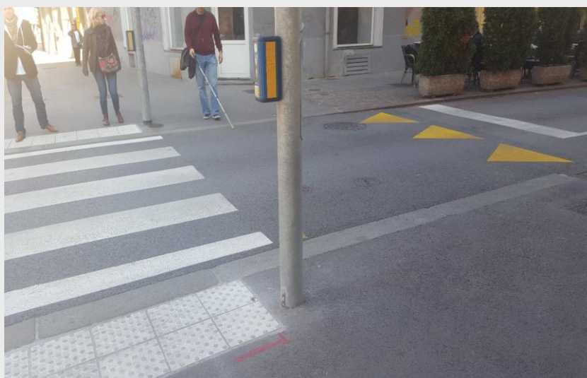
Slika 55 (neustrezno): Primer nezaščitenega roba. Rob trapezne grbine je pomaknjen daleč izven prehoda za pešce, zato bi bilo treba taktilne oznake močno podaljšati izven prehoda za pešce.
