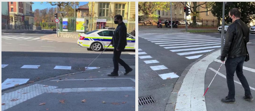
Slika 56: Taktilne oznake v križišču s poglobljenimi robniki v primeru kolesarskega pasu na pločniku. 1. (neustrezno) Na mestu kolesarskega prehoda je taktilna oznaka prekinjena, uporabnik bele palice pa je zaradi nepredvidenega dogodka izgubil orientacijo in v iskanju oprijemljivega roba zašel v križišče. 2. (ustrezno) Taktilne oznake označujejo rob ceste tudi na prehodu kolesarske steze. Uporabnik bele palice, ki je zaradi nepredvidenega dogodka izgubil orientacijo, otipa rob, po kateremu lahko sledi do varne orientacijske točke (npr. semaforja).
