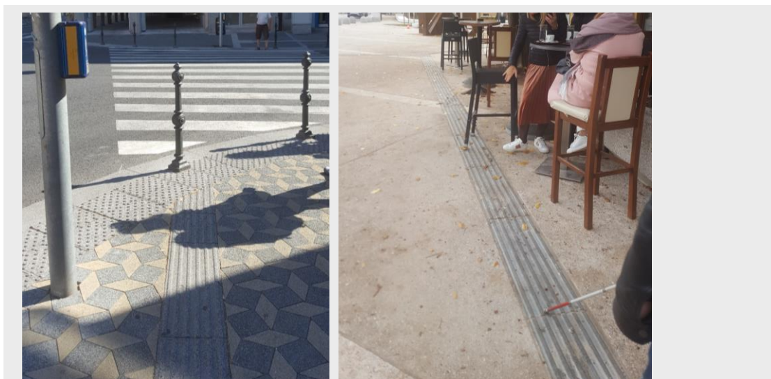
Slika 74 (neustrezno): 1. Naknadno umeščen količek ovira uporabo taktilne vodilne linije, saj je nameščen neposredno na vodilni poti. Umaknjen bi moral biti vsaj 60 cm od smeri, ki jo določa vodilna linija. 2. V načrtu ni bil upoštevan gostinski vrt, ki po izvedbi posega na taktilno oznako.
