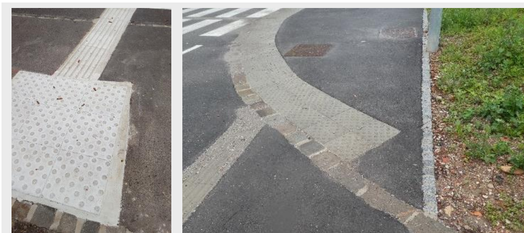
Sliki 48 (neustrezno): 1. Primer nenatančne izvedbe taktilnih oznak z načinom naknadne vgradnje. 2. Primer nenatančne izvedbe z načinom predhodne vgradnje, pri kateri je bila struktura ob asfaltiranju zelo poškodovana, taktilne oznake pa niso bile izvedene do roba. Če hodi uporabnik bele palice ob robu zelenice, je zelo verjetno, da čepastih oznak ne bo zaznal – opozorilni čepasti pas tako ne bo opravil svoje funkcije.
