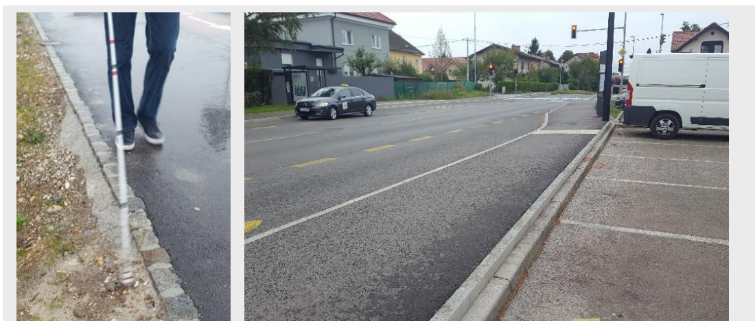
Sliki 19 (neustrezno): Površina ob pločniku leži nižje od pločnika, kar je nevarno za ljudi z okvarami vida, ki pri orientaciji sledijo robu.
