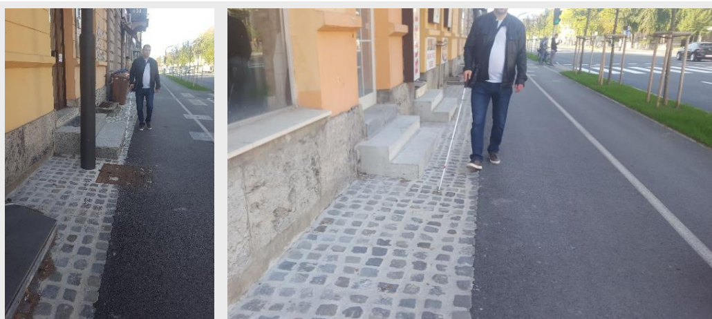
Slika 66: Primer rešitve sklenjenega taktilnega vodenja v območjih, kjer je običajni rob preveč členjen (pogoste stopnice ob robu, ulične svetilke, smetnjaki itd.) in je zato hoja ob robu zelo težavna. Vse ovire stojijo v območju taktilno zaznavnega tlaka, uporabnik bele palice pa lahko sledi robu tega tlaka in se tako izogne oviram.
